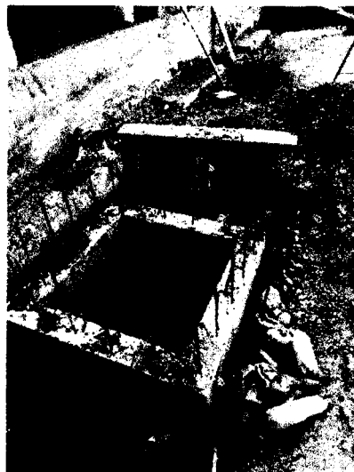
FOTO N°4: Se supervisa los trabajos de excavación de para cámara de bombeo N° 03.
